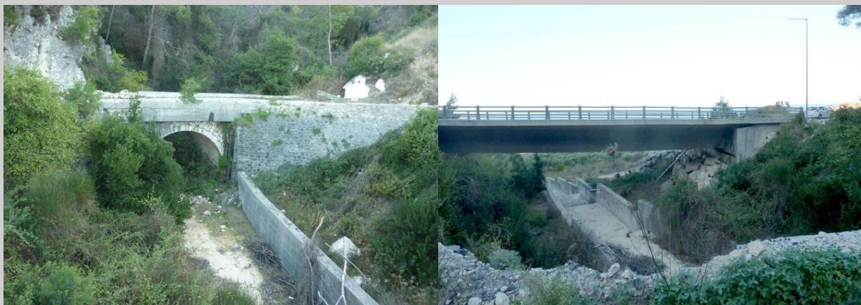
Σχήμα 53: Παλιές και νεώτερες γέφυρες, λιθόκτιστες και από οπλισμένο σκυρόδεμα, επέδειξαν πολύ καλή συμπεριφορά.
