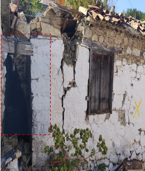
Σχήμα 22: Ανατροπή τοίχου μετά την αποδιοργάνωση της τοιχοποιίας
