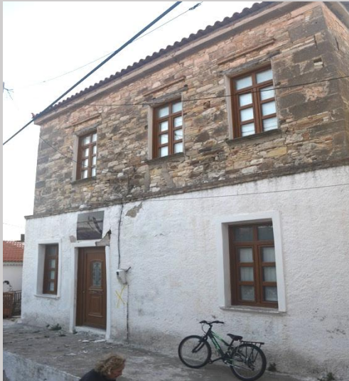
Σχήμα 66: Βλάβες στο Λαογραφικό Μουσείο στα Κουμέικα λόγω εδαφικής αστάθειας και συνεπακόλουθων διαφορικών καθιζήσεων.
