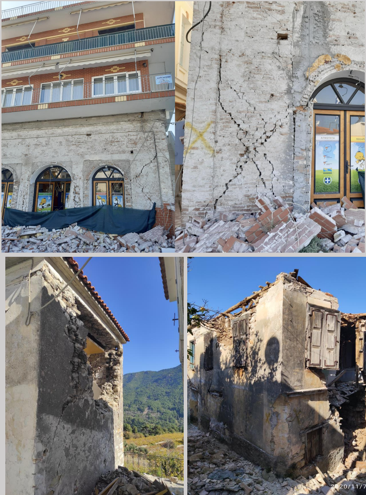
Σχήμα 26: Αστοχία τοιχοποιίας (άνω) και εκτός επιπέδου αστοχία και κατάρρευση της άοπλης τοιχοποιίας (κάτω).
