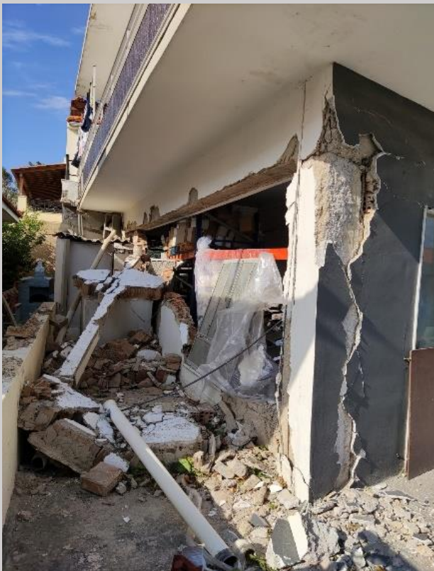
Σχήμα 18: Αποδιοργάνωση και ανατροπή τοιχοπληρώσεων
