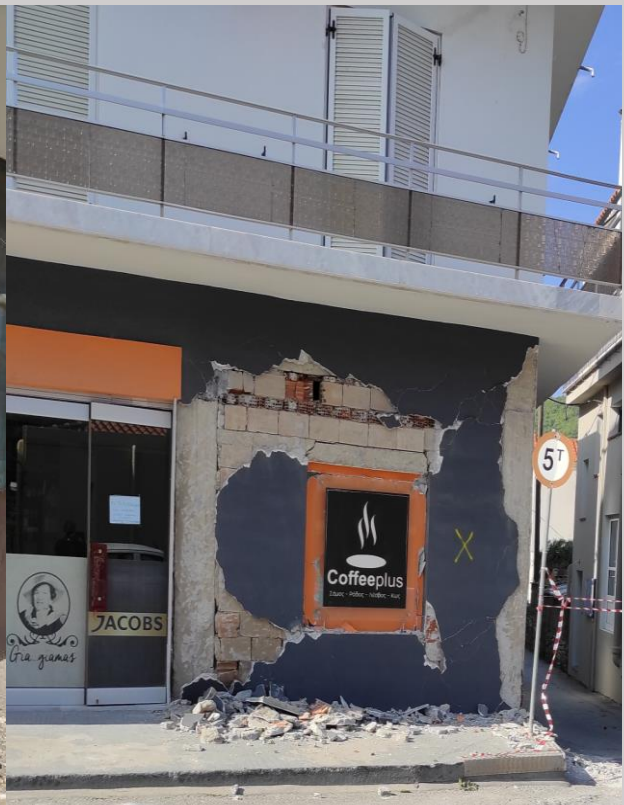
Σχήμα 19: Αποδιοργάνωση και ανατροπή τοιχοπληρώσεων
