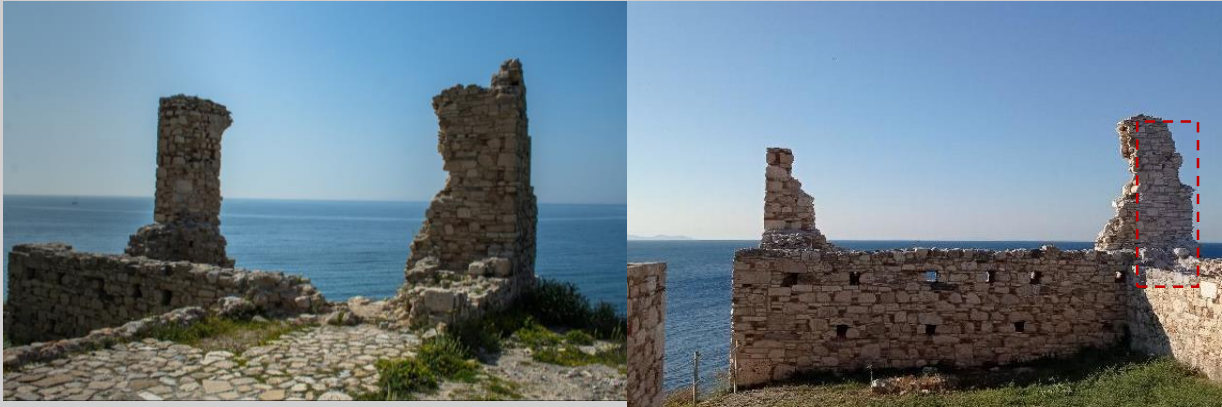
Σχήμα 28: (α) Πριν τον σεισμό (Google Earth), (β) Μετά τον σεισμό της 30 ης Οκτωβρίου 2020. Κατακρήμνιση τμήματος των περιμετρικών τειχών στο Κάστρο του Λυκούργου Λογοθέτη προς τη θάλασσα.
