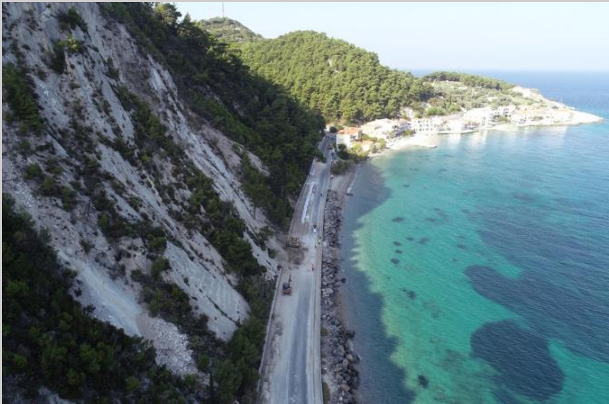
Σχήμα 57: Αστοχία βραχώδους πρανούς στα Αυλάκια. Διαπιστώνεται ότι οι ασυνέχειες του πετρώματος ήταν ομόρροπες ως προς στην κλίση του πρανούς (αεροφωτογραφία: Ι. Ν. Σπύρου)
