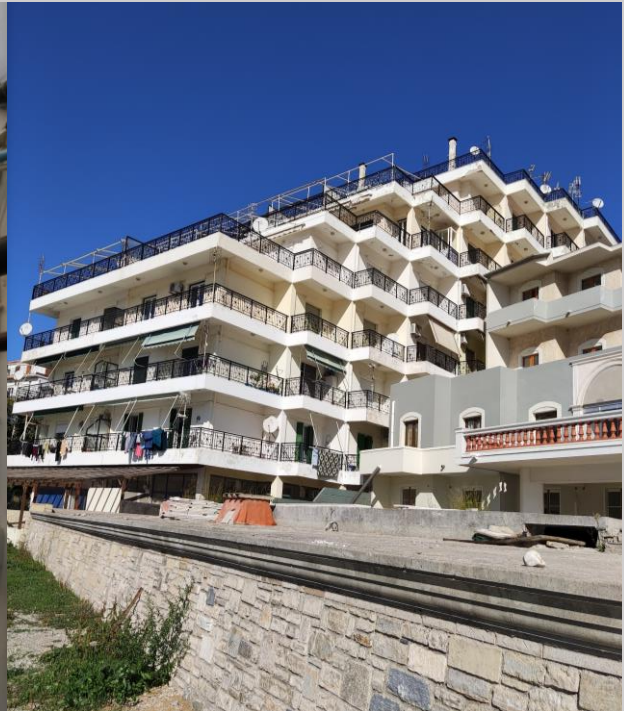
Σχήμα 17: Επτάώροφη πολυκατοικία στο Βαθύ χωρίς βλάβες.
