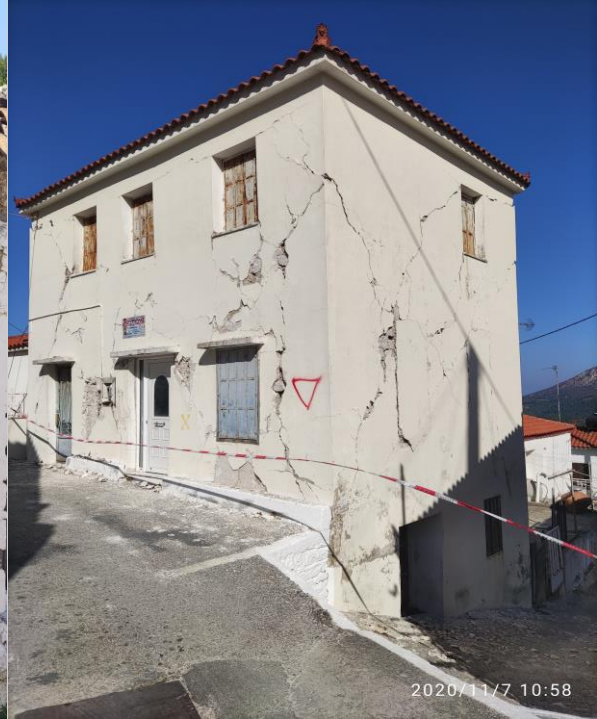
Σχήμα 23: Διαγώνια ρηγμάτωση εντός επιπέδου κατά τις δύο κύριες διευθύνσεις.
