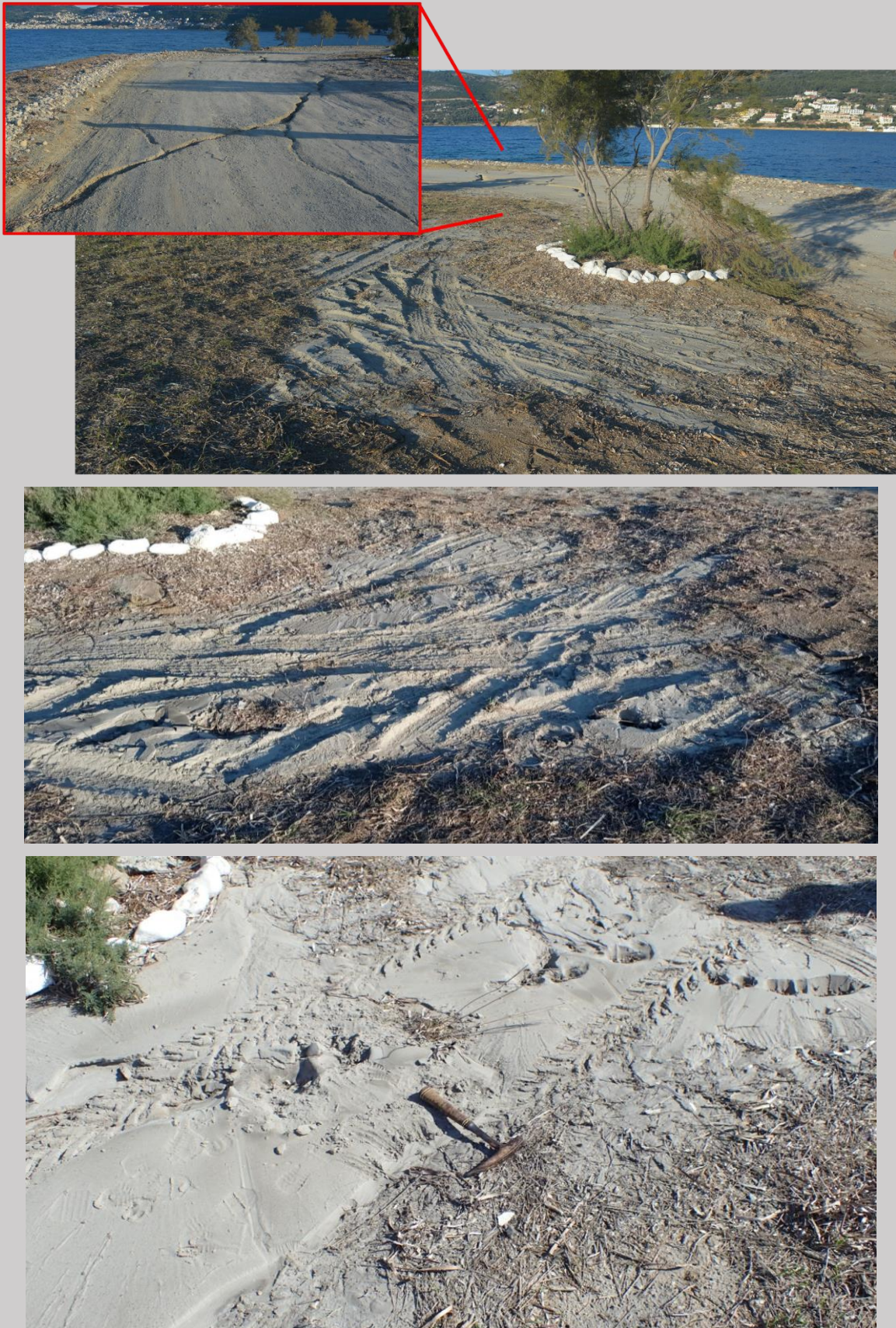
Σχήμα 60: Φαινόμενα εδαφικής ρευστοποίησης στο Μαλαγάρι. Παρά τις ανθρωπογενείς αλλοιώσεις μετά το σεισμό, διακρίνονται κώνοι αμμοϊλύος και εδαφικές ρωγμές λόγω πιθανής οριζόντιας εξάπλωσης.
