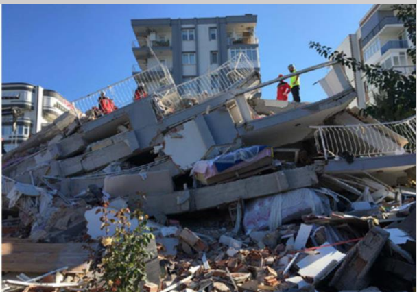
Σχήμα 70: Γενική άποψη επικέντρου σε σχέση με την πόλη της Σμύρνης (65km, άνω), δορυφορική άποψη της περιοχής Bayraklı όπου προκλήθηκαν οι περισσότερες δομικές βλάβες και καταρρεύσεις (μέσο) καθώς και εικόνες από κτίρια που κατέρρευσαν (Istanbul Technical University (ITU) 2020).
