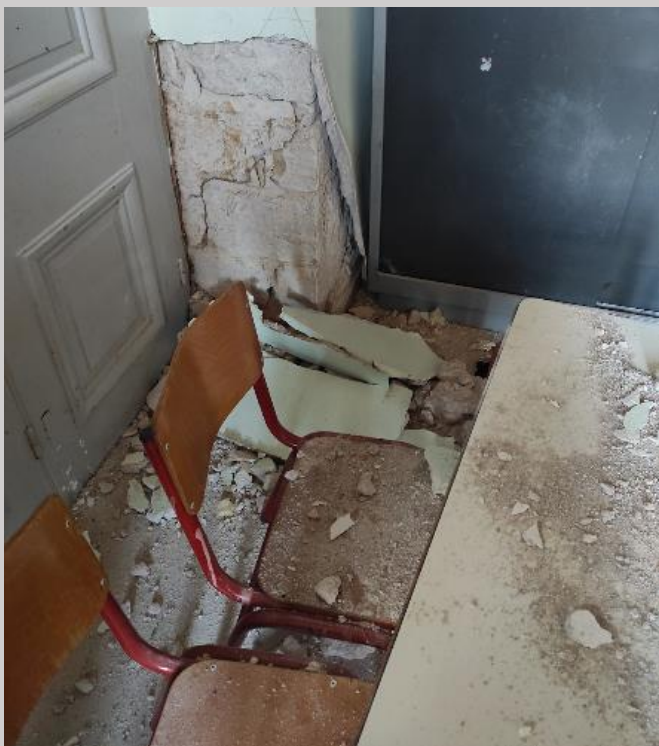
Σχήμα 47: Δημοτικό Σχολείο στα Κοντακαίικα: Σημαντικές βλάβες στη φέρουσα τοιχοποιία, με ταυτόχρονη πτώση επιχρισμάτων και ανατροπή εξοπλισμού.
