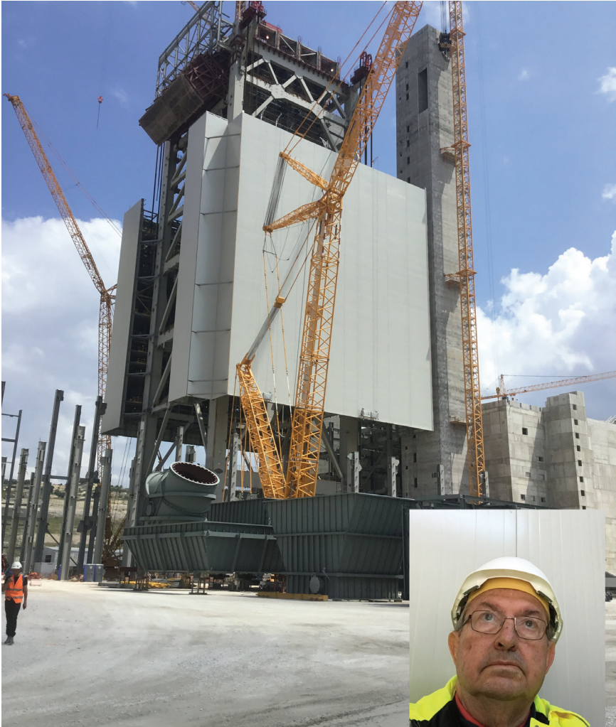
Ανέγερση Boiler, θερμοηλεκτρική Μονάδα V, ΔΕΗ, στην Πτολεμαΐδα (2018)
