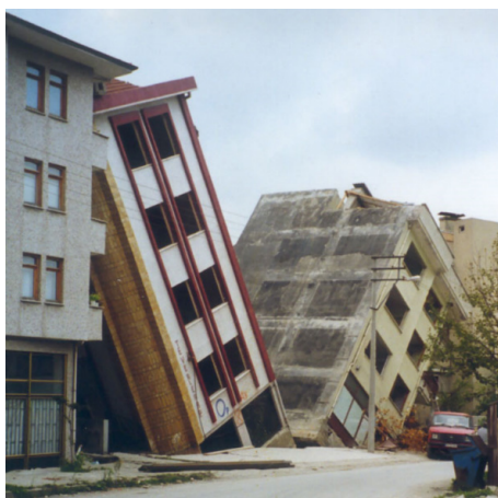
Ανατροπή γειτονικών (πλάτη-με-πλάτη) κτιρίων στο Adapazarı (17.8.1999).
