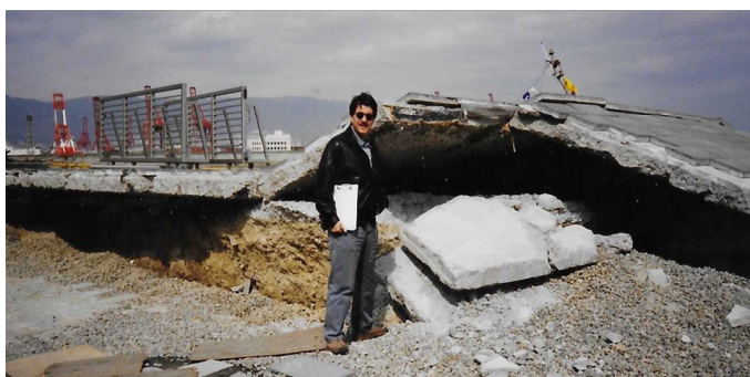
1995: Λιμενικοί κρηπιδότοιχοι στο Κόμπε μετά τον σεισμό του 1995.
