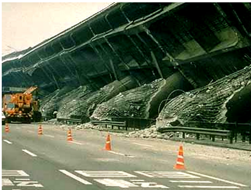
Hanshin Expressway Route 3, Kobe 1995: Συνέβαλε άραγε στην κατάρρευση η σχετικά-ανένδοτη πασσαλο-θεμελίωση ??
